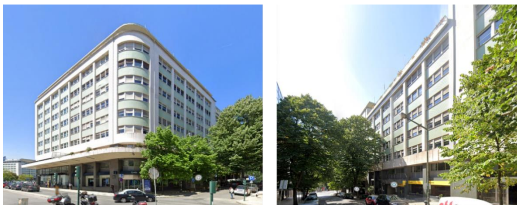
Figura 2: Fotografias atuais do edifício existente. Gaveto da Rua Camilo Castelo Branco com a Av. Duque de Loulé (esquerda); fachada da Rua Camilo Castelo Branco (direita).
